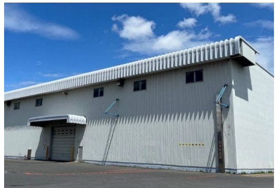
苫小牧埠頭の物流倉庫
