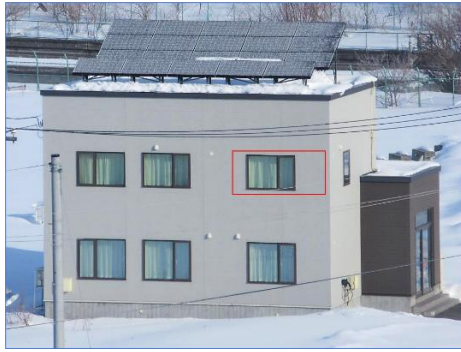
北海道電力の実証施設 (赤枠のエリアの窓および外壁面に設置)
